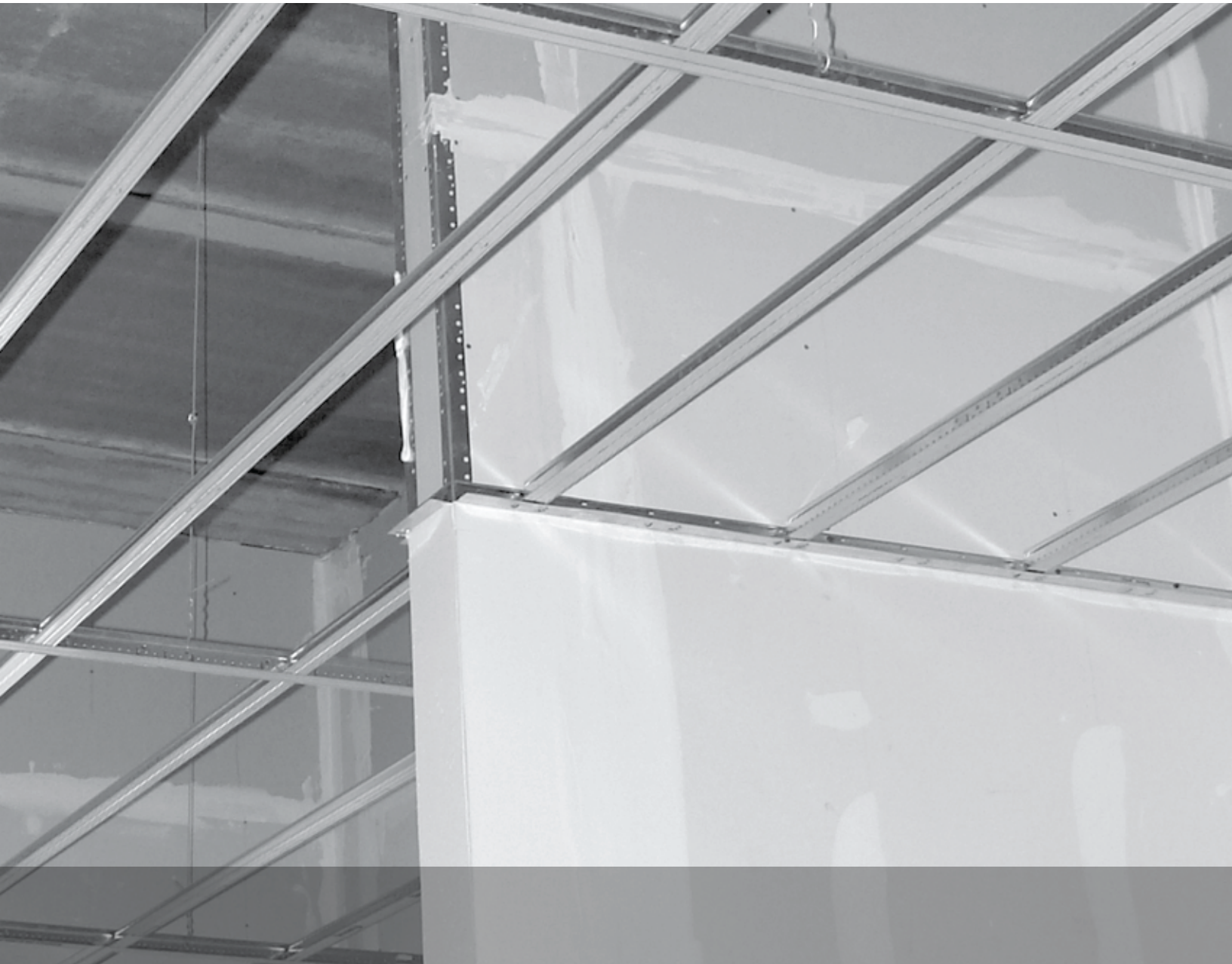
Instalación del sistema de suspensión para paneles de yeso corridos
