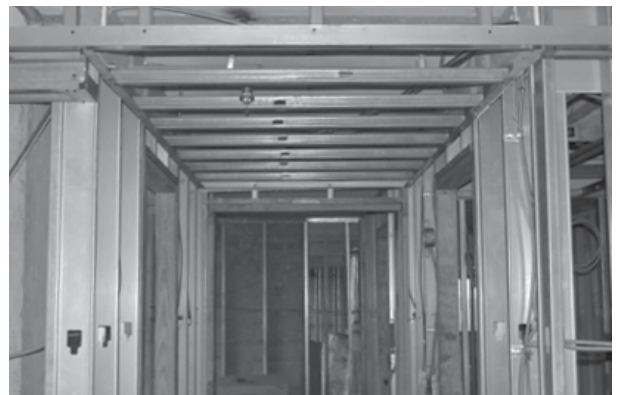
Encuadre de pasillo con montantes de acero tradicionales
