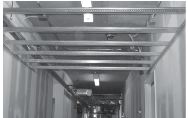
Los encuadres ShortSpan y las molduras angulares de fijación facilitan y agilizan el encuadre de paneles de yeso
