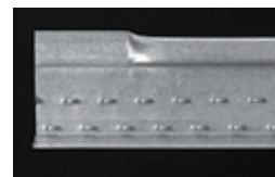
Soporte StrongBack instalado con claro intermedio y poste vertical a 4' de centro a centro.
