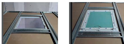
3. Fijar el marco al plafón con tornillo galvanizado punta de broca.
